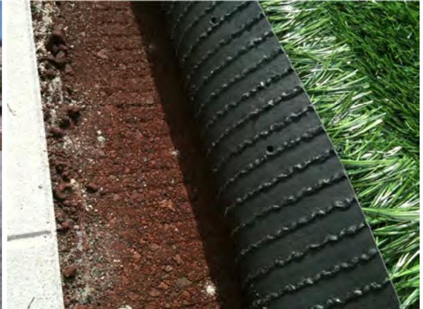
Pose du support en roche volcanique et installation du gazon synthétique par-dessus
