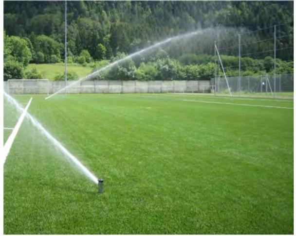
Si les systèmes d'irrigation sont installés au milieu du terrain, ils doivent être suffisamment petits afin de ne pas mettre en danger les joueurs ou poser sur des perches en dehors du terrain.
