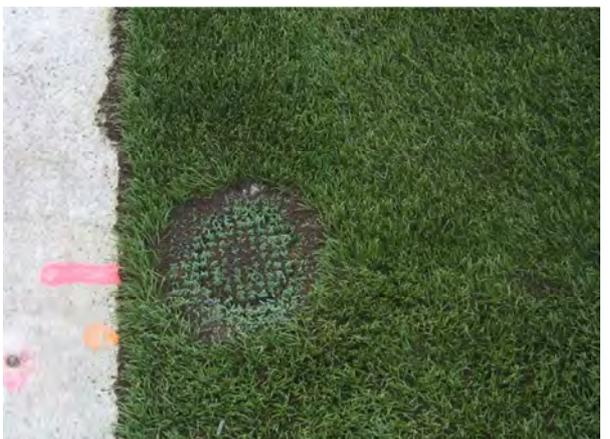
Ce type de système ne doit pas être installé au milieu du terrain car les joueurs peuvent se blesser.
