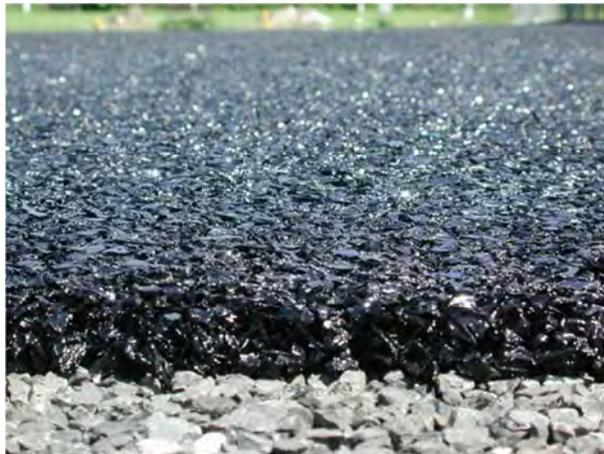
Installation « In-Situ » sur un fond en béton bitumineux et par-dessus une base de gravier stabilisé en bitume
