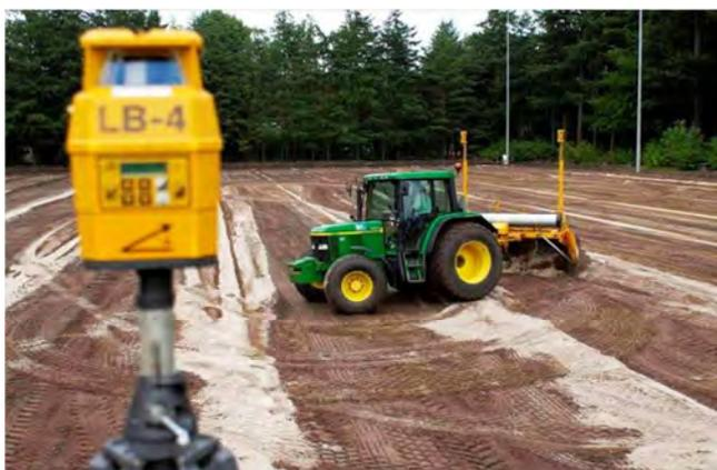
**Installation d'un système de drainage dans une base sablonneuse et nivellement du sol contrôlé électroniquement**
