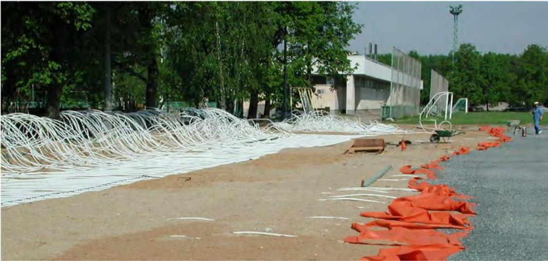
Chauffage au sol sous une base non stabilisée
