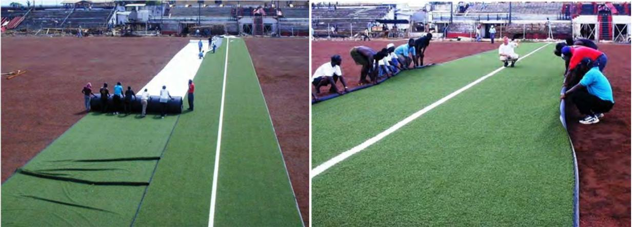
Installation du gazon sur une infrastructure non stabilisée mais par-dessus un géotextile
