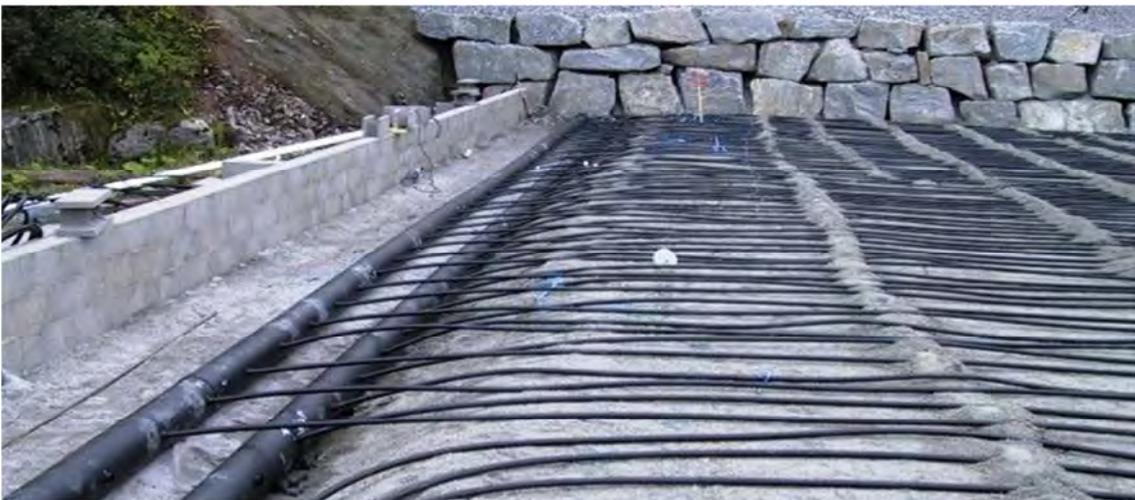
Isolation et chauffage au sol sous une base stabilisée
