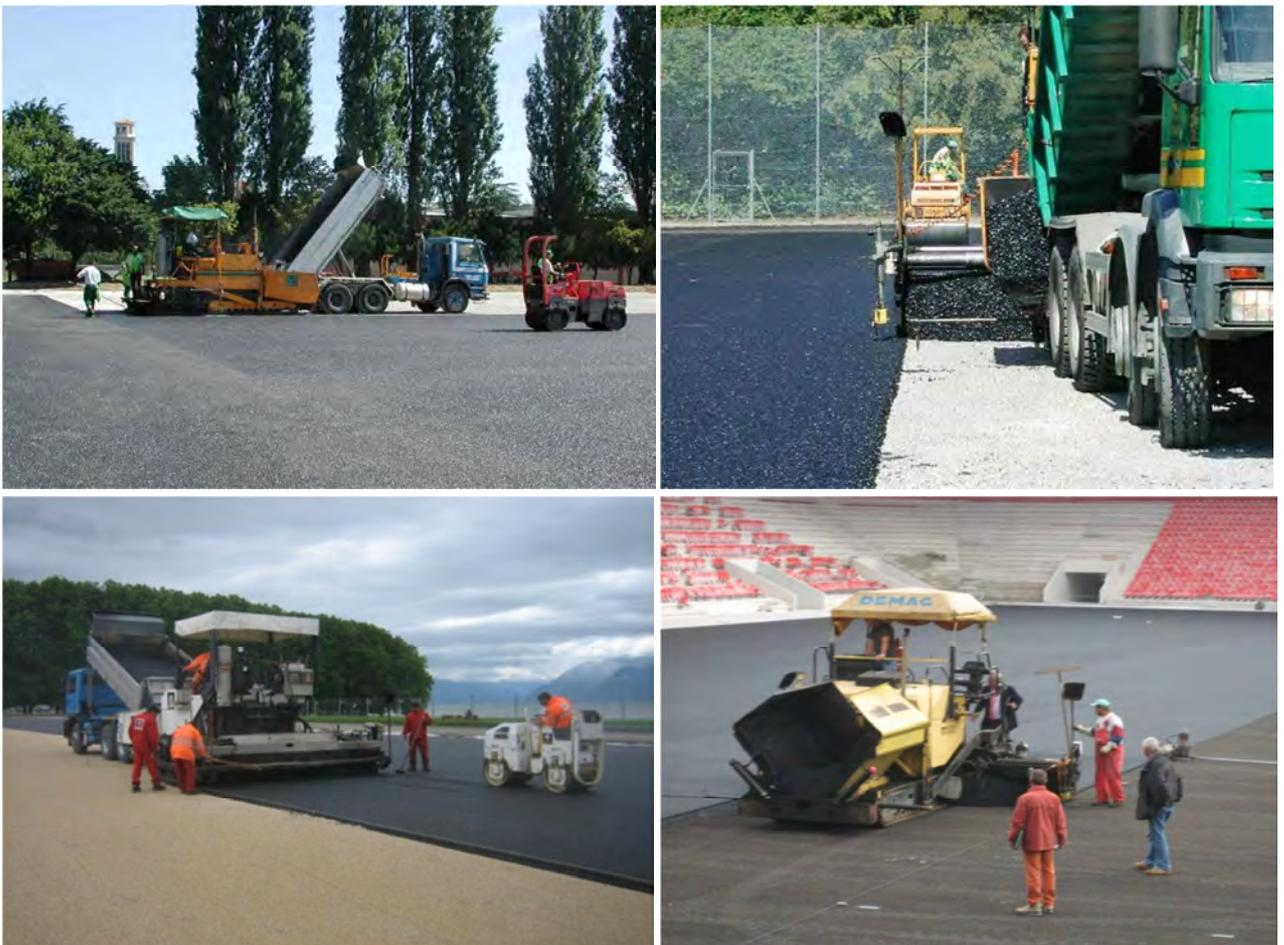
Pose avec une finisseuse pourvue d'un appareil laser pour le nivellement automatique
