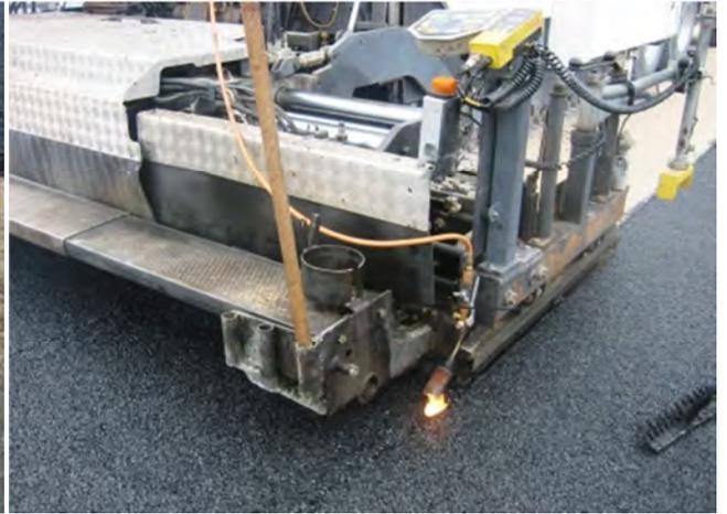
**Chauffage et compactage des joints pour obtenir un niveau parfait**
