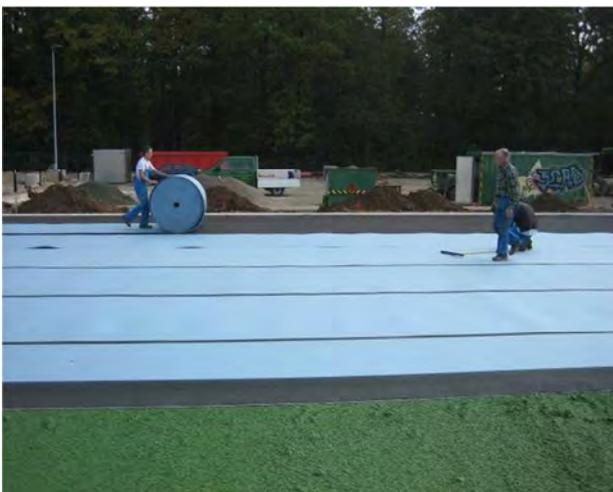
Installation de sous-couche préfabriquée sous forme de rouleaux ou de plaques
