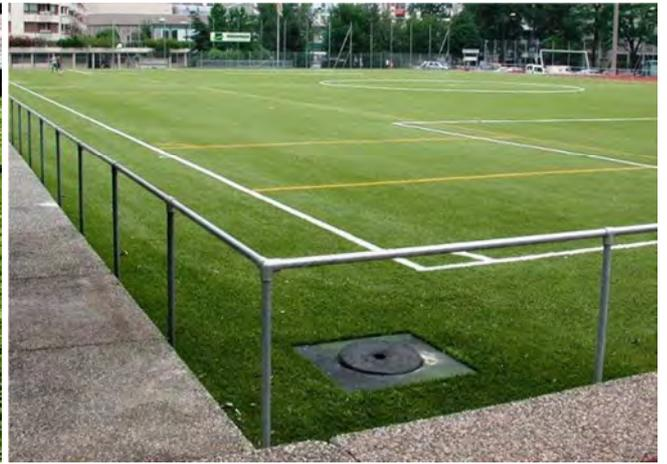
Main courante et finition spéciale pour les couvercles des installations de drainage hors du terrain de football
