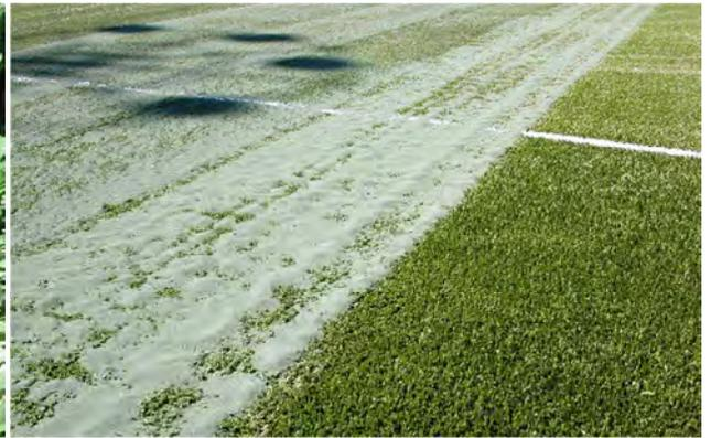
...ce qui conduit à des difficultés de contrôle de l'épaisseur et au déversement de trop de granulat à la fois, avec pour conséquence de nombreuses fibres de Football Turf complètement recouvertes par le granulat
