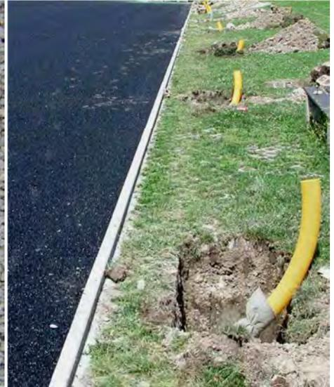
**Pipes de rinçage pour tuyaux de drainage**
