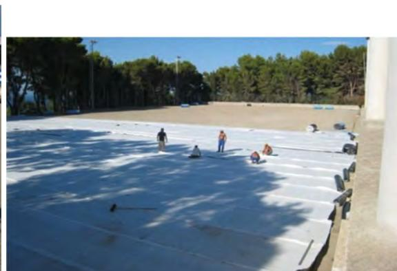
**Remarques:** la natte préfabriquée est soit imperméable en dessous ou un foil en plastique doit être installé directement sur la base stabilisée afin d'éviter une infiltration de l'eau.
