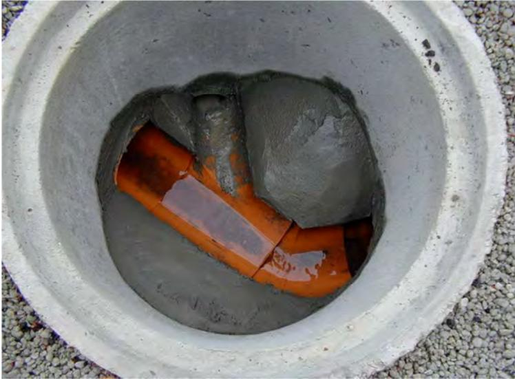
**Puits de contrôle du drainage**
