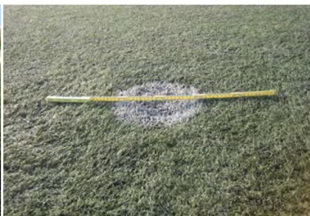
Remplacement du matériau de remplissage aux endroits les plus usés
