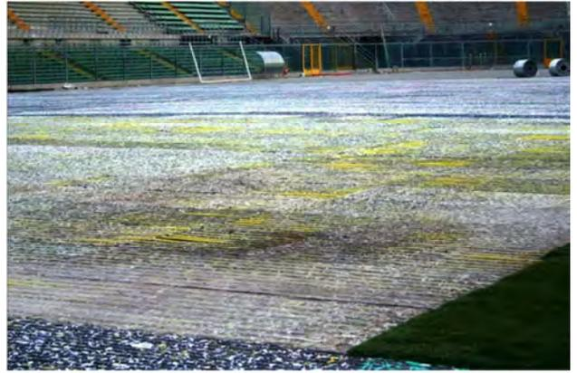
Chauffage au sol incorporé dans une sous-couche élastique placé juste sous le Football Turf
