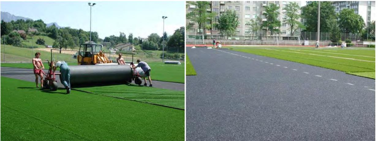
Pose du gazon sur une infrastructure stabilisée avec une sous-couche élastique
