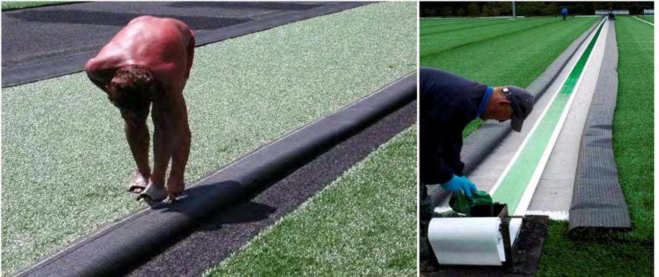
Découpage des bords irréguliers ou endommagés des rouleaux et préparation de l'encollage des joints
