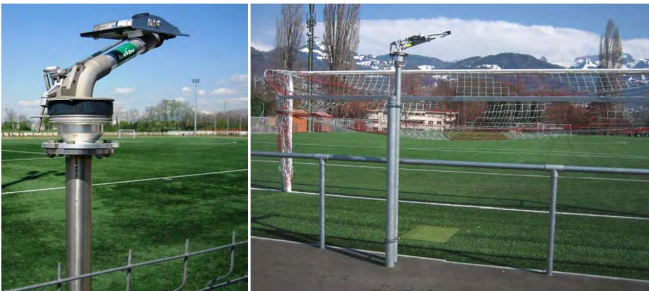
Têtes des arroseurs installées à l'extérieur du terrain sur des perches
