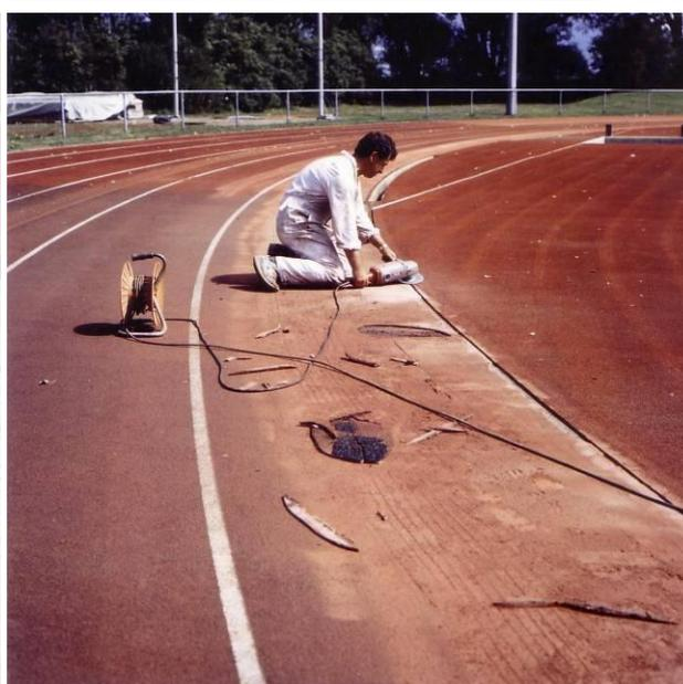
**Pose d'une nouvelles sous couches et finition aux endroits endommagés**
