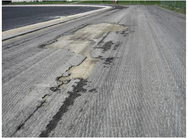
**Détachement partiel de l'asphalte lors du rabotage**
