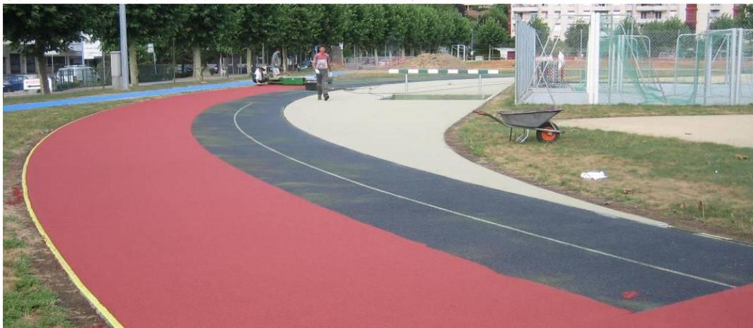
Les deux couches (sous couche noir en SBR et finition en EPDM rouge lié au polyuréthane) se posent avec une finisseuse à froid, mais lissé à chaud
