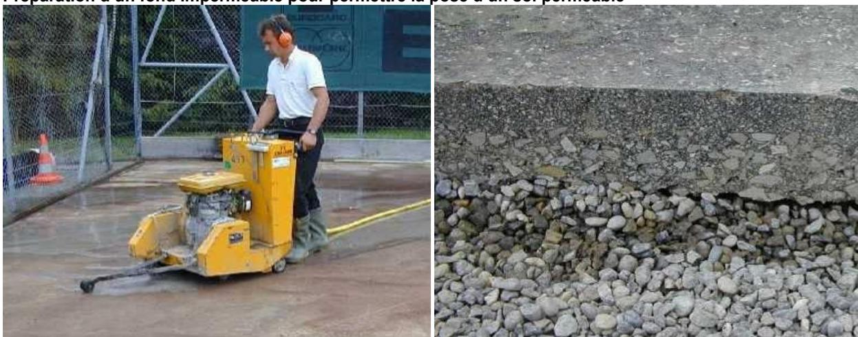
Installation d'un drainage tous 4 à 5m de distance et remplissage avec du béton poreux
