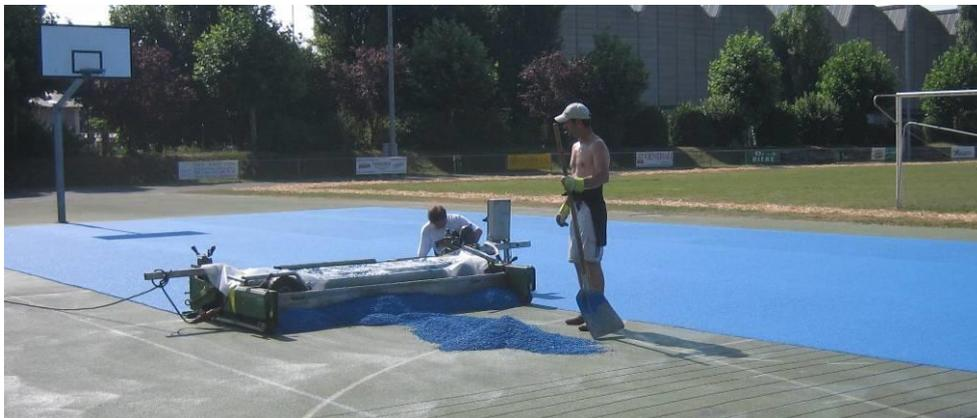
Application de la mélange de caoutchouc et granulés de caoutchouc...
