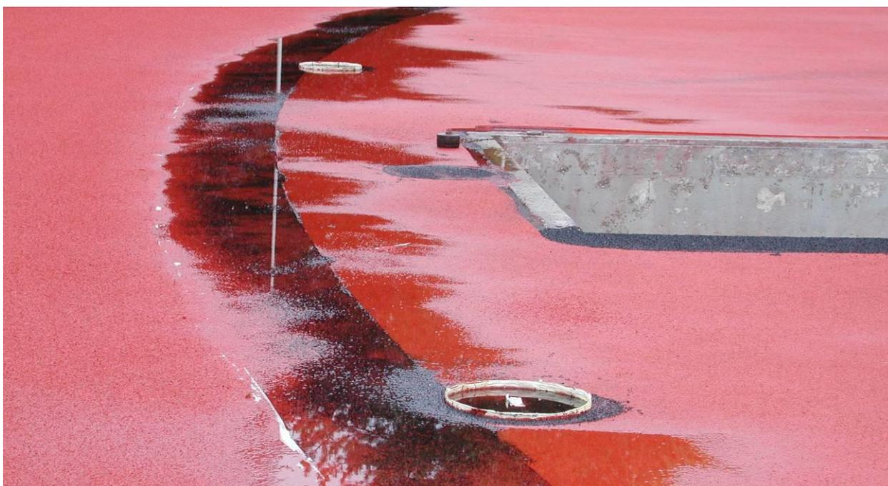
Rettopping de la surface par application de polyuréthane chargé de granulats de caoutchouc EPDM
