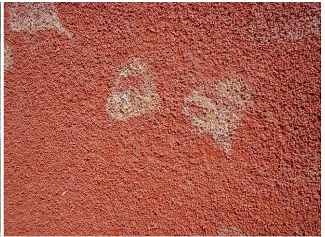
**Réaction chimique des feuilles mortes sur un sol fraîchement coulé**
