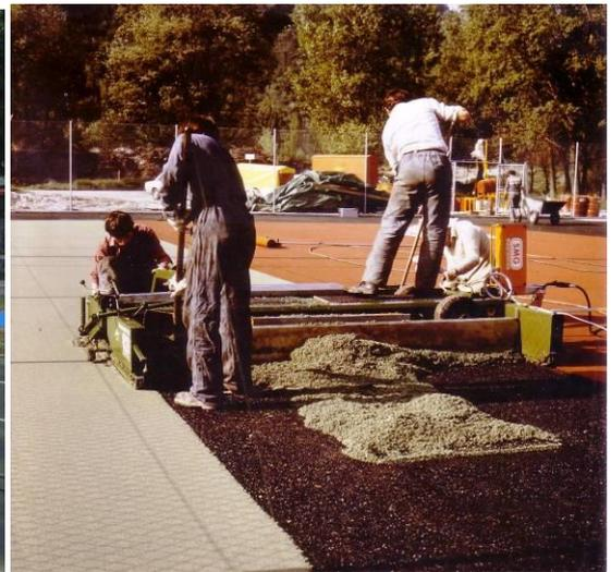
**Pose à la machine des granulats EPDM liée au PUR**
