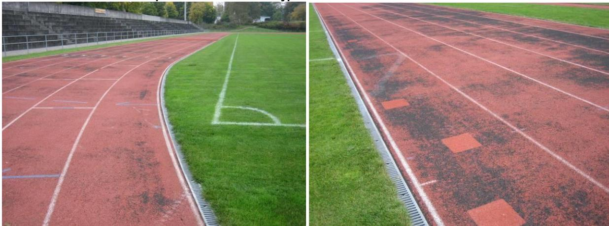
L'origine de l'usure de cette installation provient d'un surfacage (épaisseur) initiale insuffisant
