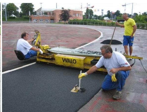
Pose à la machine des granulats SBR liée au PUR
