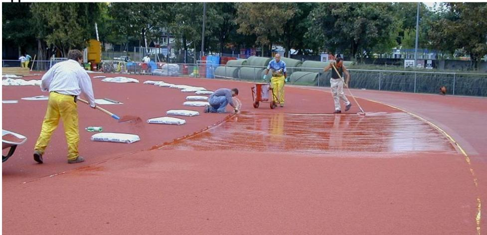
**et le recouvrement / lestage avec des granulats EPDM...**
