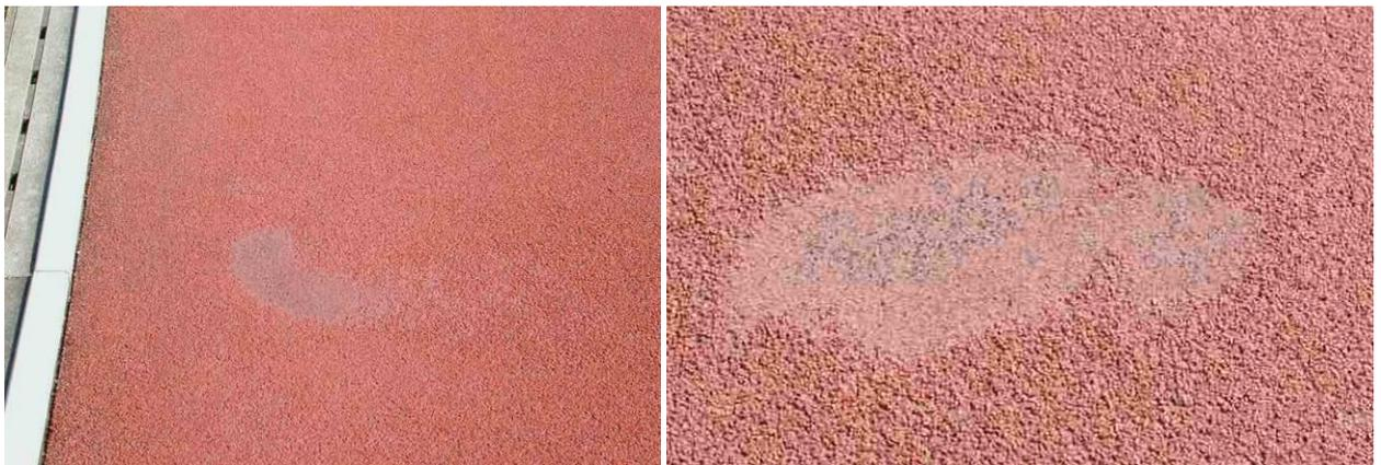
Il en résulte que l'eau s'écoule maintenant très lentement ou reste dans la cuvette formée par l'usure.
