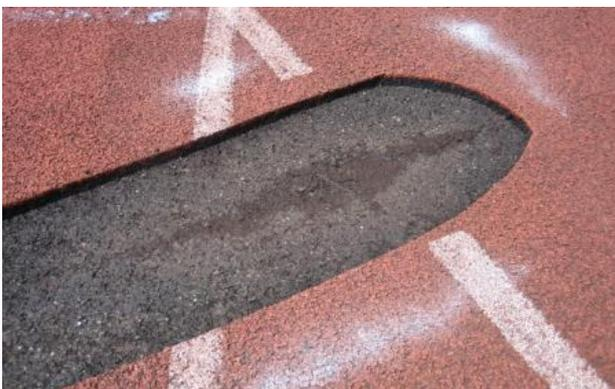
**Causes** : enrobés fissurés ou humides (remonté d'humidité)
