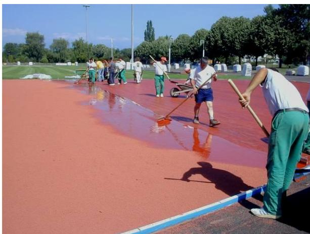
Application de la finition en polyuréthane coulée, lesté avec du granulat en caoutchouc EPDM
