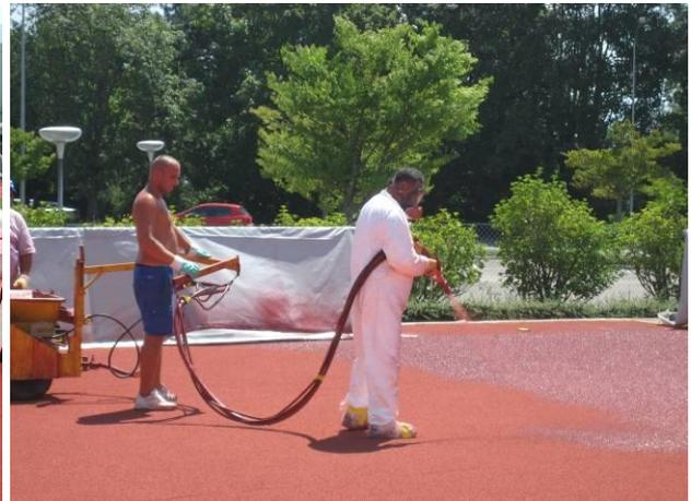
**Application d'un mélange de granulat et PUR, et application d'un film de protection en PUR**
