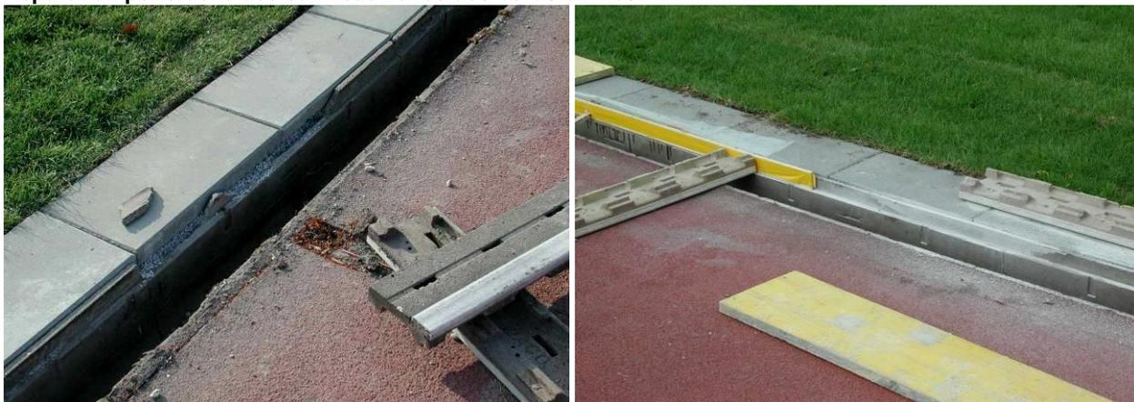
Préparation d'un fond imperméable pour permettre la pose d'un sol perméable
