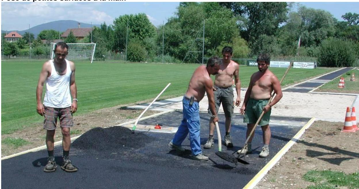
**Contrôle de la planité (max. 4mm sous la règle de 4m)**
