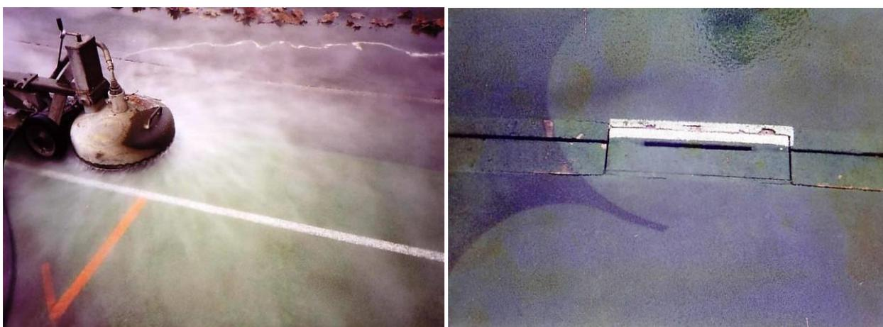
Lavage à haute pression (min. 300 bar, possible jusqu'à 600 bar)
