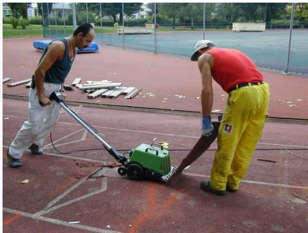
**Rabotage du sol sportif avec une fraiseuse pour béton bitumineux**
